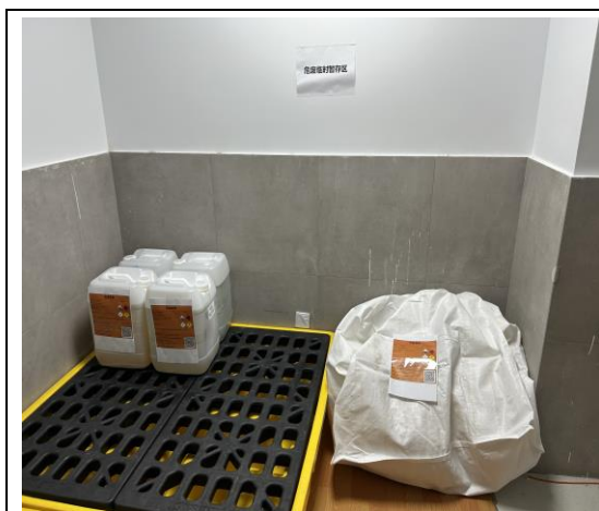
分区存放、附危险废物标签、有防渗措施
